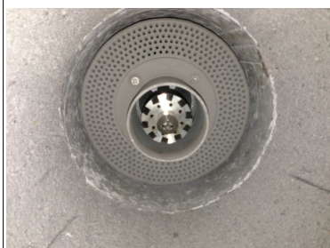
↑ 炉内の取り付け風景
