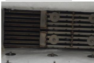
↑プレート型熱交換器
