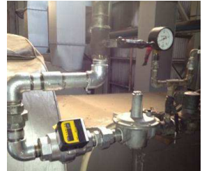
全てのバーナーに流量計を取り付け状態を把握する
